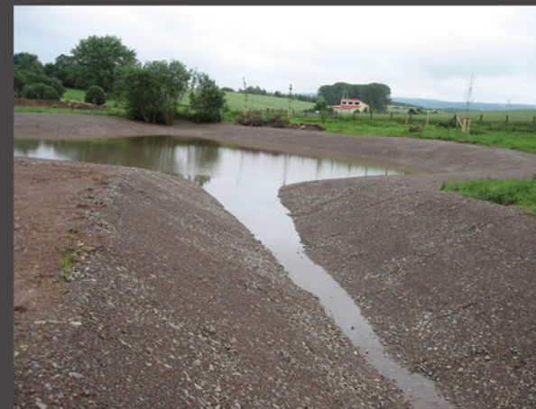
Frisch fertig gestelltes Becken nach erstem kleinen Hochwasserzulauf
